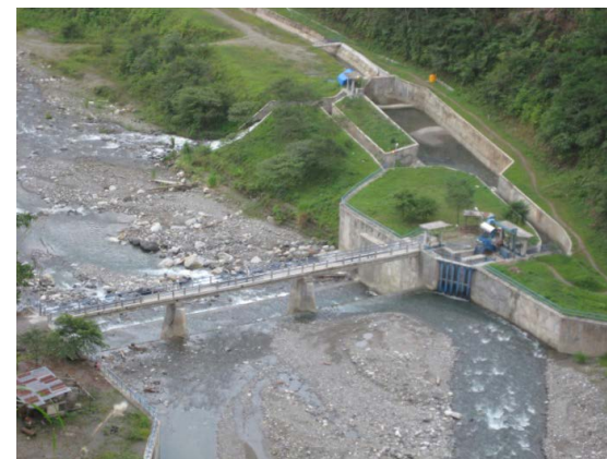
Hydro-elektriciteitscentrale in gemeente Pegunungan Arfak gebouwd door Pt. Widya Kencana Pratama
